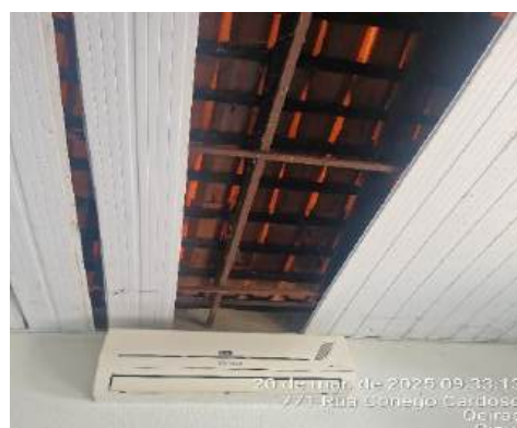
Figura 11 Detalhe no teto da recepção da Delegacia Seccional de Oeiras
