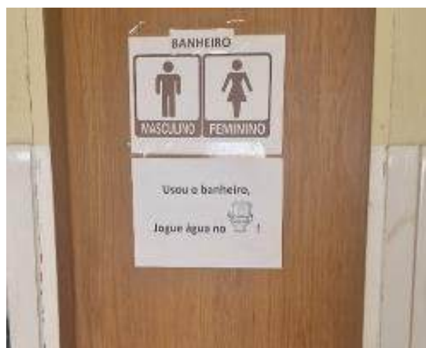
Figura 10 Na DEAMGV de São Raimundo Nonato, há problemas das instalações sanitárias, que estão quebradas.
