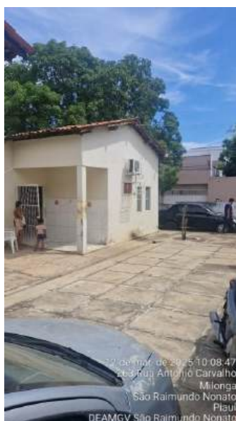
Figura 2 Na DEAMGV – São Raimundo Nonato, não há uma recepção com estrutura de segurança adequada aos profissionais. Usuários (incluindo
