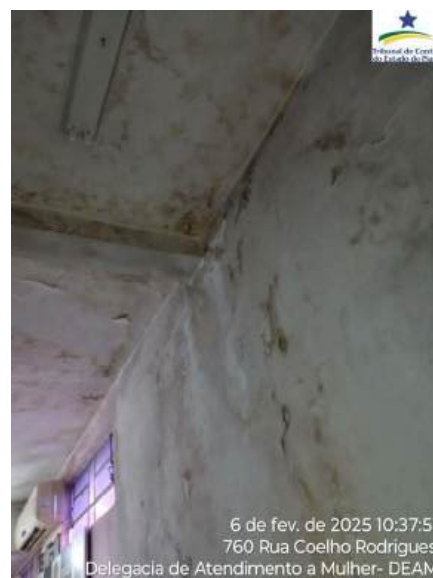
Figura 7 DEAM/Centro: Teto do corredor que dá acesso à sala de ocorrências e cartório da 1ª DEAM
